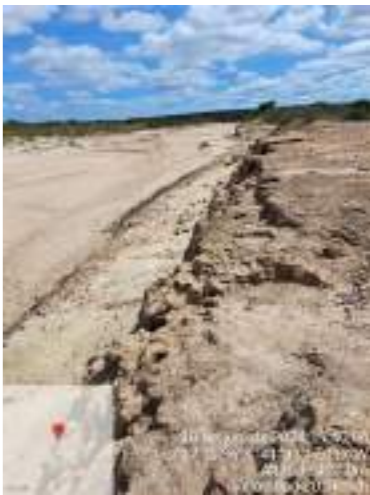
Margem direita com indícios de degradação acelerada do solo, que pode provocar assoreamento da calha principal.
