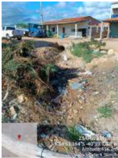
Lixo obstruindo o canal de esgoto.
