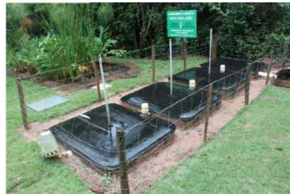
Imagem: Fossa séptica biodigestora.
